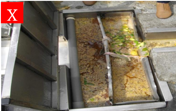
圖 3-6-9 截油槽設置不良示意圖
